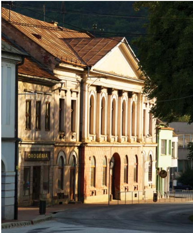
Reduta-mestský hostinec Skalka, klasicistická dvojpodlažná stavba z roku 1845, v dvorovej časti otvorené arkády
