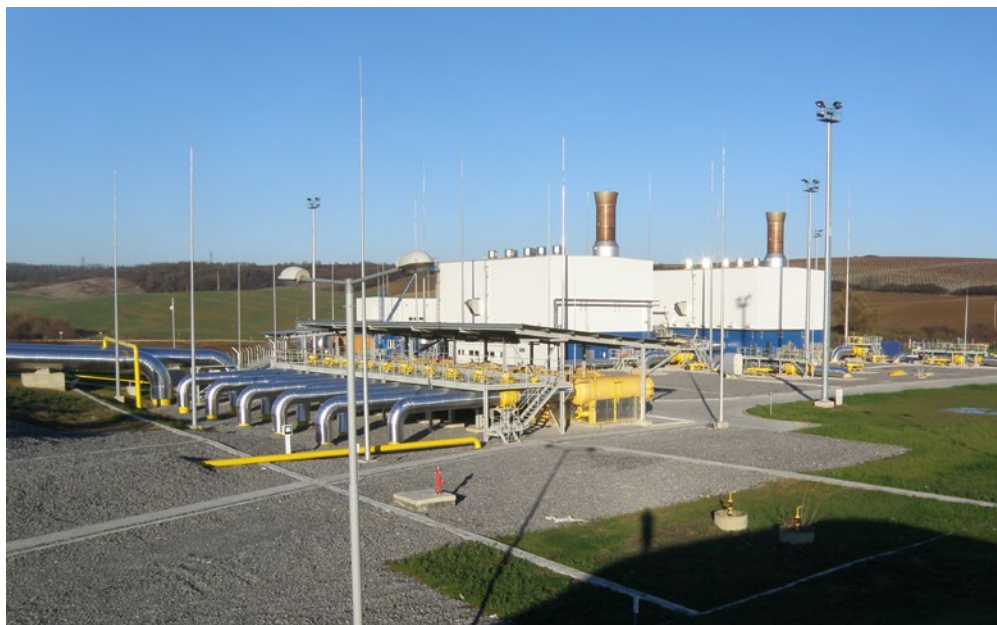
Inštalácia tandemových turbosústrojenstiev KS 03 Veľké Zlievce ZIPP BRATISLAVA spol. s r.o.
