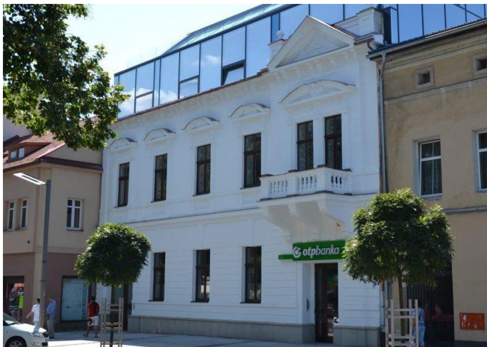
Rekonštrukcia Meštianskeho domu v meste Zvolen, v realizácii spol. JANISTAV, s.r.o. Nové Mesto Nad Váhom – člen skupiny CDI
