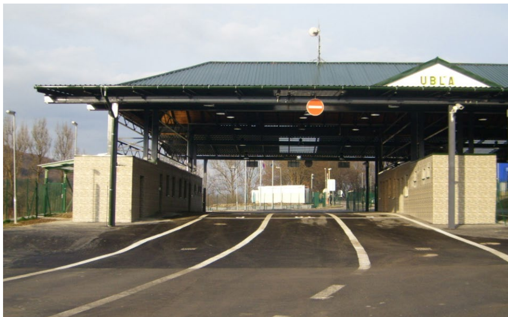
Colný hraničný prechod Ubľa - rekonštrukcia STAVOMONT SP Snina spol. s r.o.
