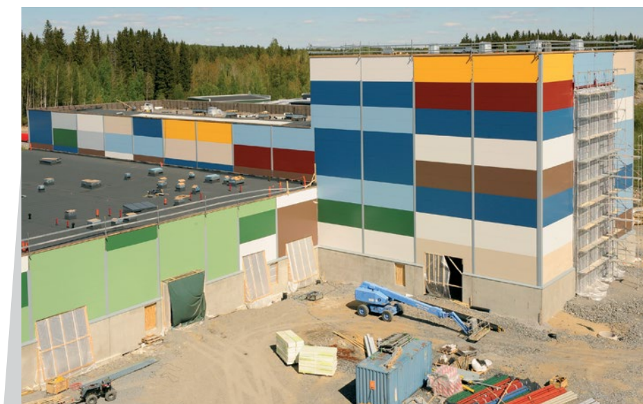
Ruukki dodávateľ a výrobca opláštenia - Cargotec Technology Center, Tampere Fínsko.
