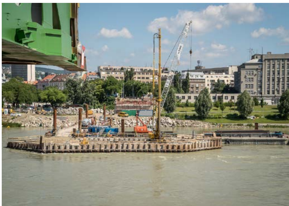
Starý most, Bratislava pilier 34 - vylepšenie podzákladia prúdovou injektážou Keller špeciálne zakladanie s.r.o.
