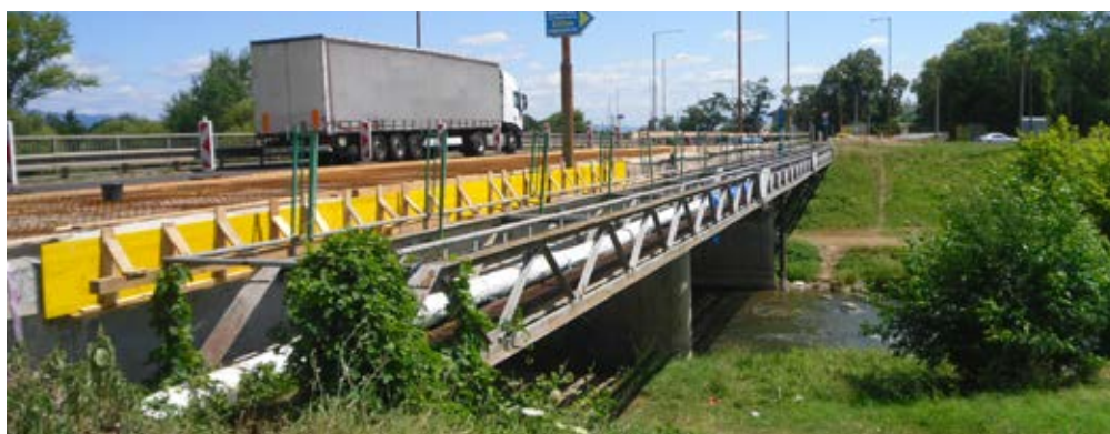
Most cez rieku Laborec I/50 Michalovce - Lúčky STAVBY MOSTOV SLOVAKIA a. s.
