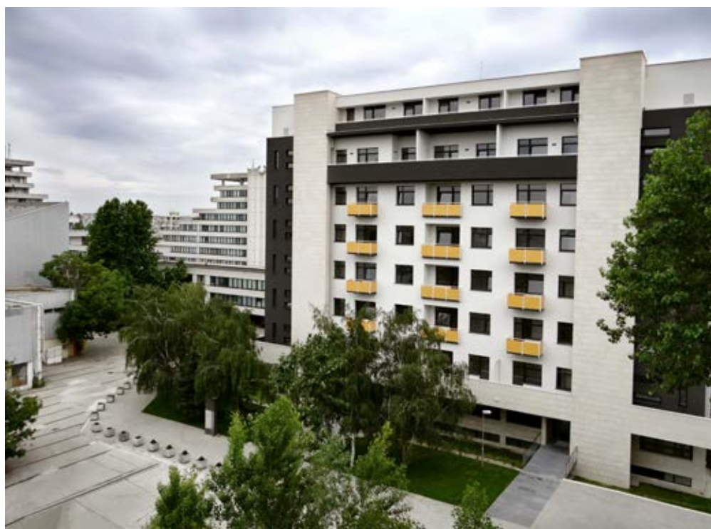
Bytový dom Jašíkova, Prima Park Bratislava Metrostav Slovakia a.s.
