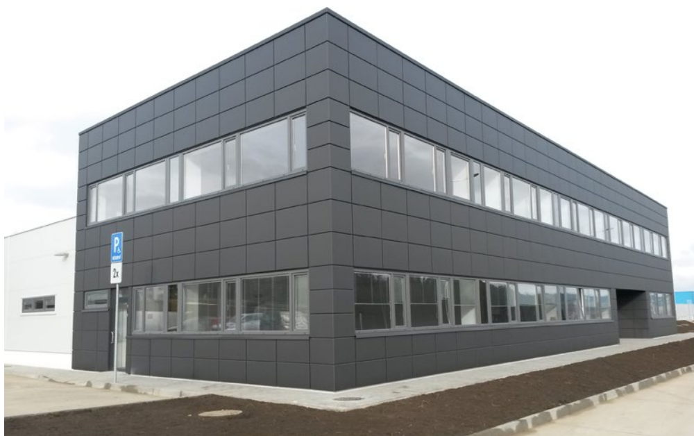
Výrobno-administratívna budova Kežmarok, Ruukki Forma™ Liberta 500 PU 100
