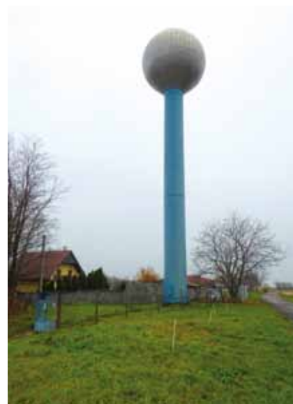
Obr. 2 - Vežový vodojem
