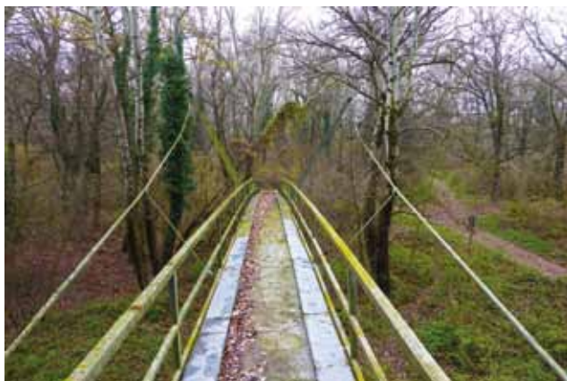
Obr. 3 - Lávka - visutá lanová konštrukcia s projektovanými rozmermi 7,0m + 72,0m + 7,0m
