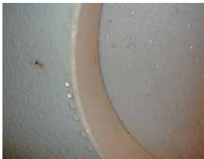
Obr. 10 – Jarovce: Korózia kotevných skrutiek a kondenzát pri výstupe na strechu
