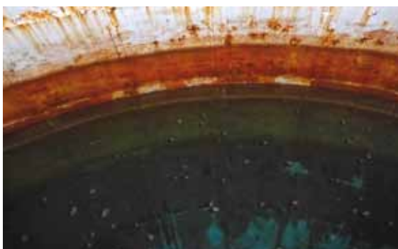
Obr. 7 – Rusovce: Korózia vnútra nádrže a pootočené kotevné bloky
