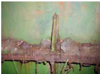
Obr. 9 – Báhoň: Korózia prírubového spoja a medzera v prírubovom spoji
