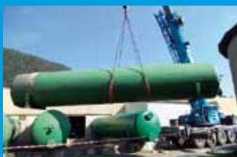
MONDI SCP, Ružomberok - starý pieskový filter 450m³/hod.
