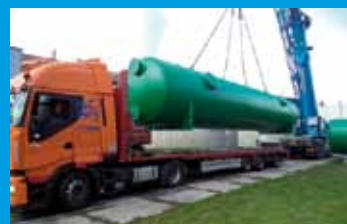
MONDI SCP, Ružomberok - nový pieskový filter 450m³/hod.
