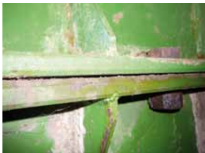
Obr. 9 – Báhoň: Korózia prírubového spoja a medzera v prírubovom spoji
