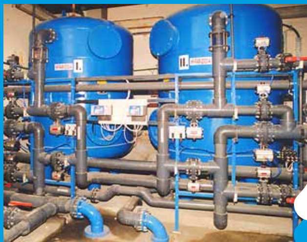
MONDI SCP, Ružomberok - starý pieskový filter 450m³/hod.
