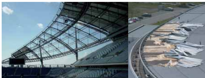
Obr. 15 Účinky vetra na otvorených strechách štadiónov a strechách
