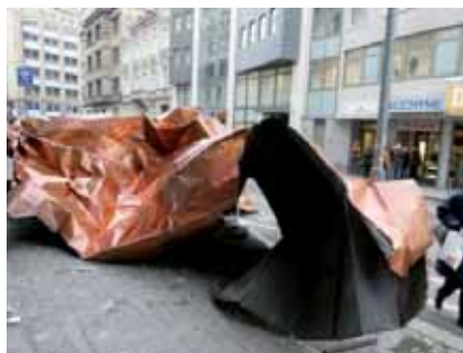
Obr.17 Poškodenie strešných konštrukcií budov
