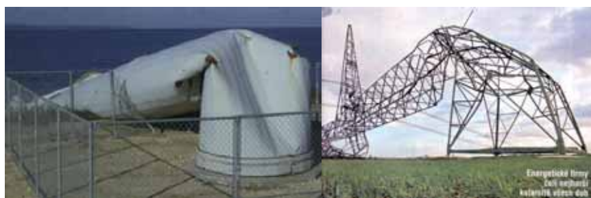
Obr. 16 Kolaps celej konštrukcie od účinkov vetra
