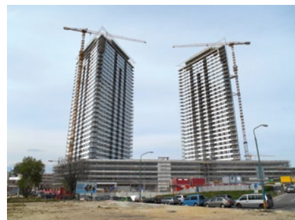
Obr.1 Budova Panorama City v Bratislave
