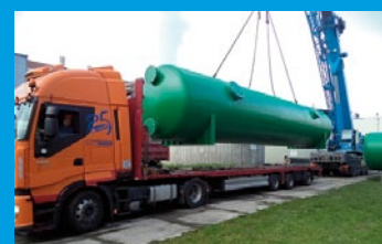
MONDI SCP, Ružomberok - nový pieskový filter 450m³/hod.
