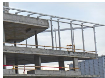
Obr.2 Ocelej konštrukcia na 33. a 34. NP
