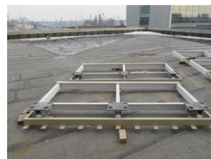
Obr.3 Kotevné vložky na balkóne JV steny a konštrukcia zábradlia
