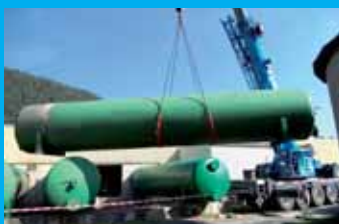
MONDI SCP, Ružomberok - starý pieskový filter 450m 3 /hod.
