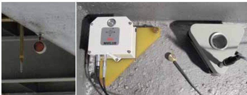
Obr. 4.2 Stabilizácia pozorovaných bodov
