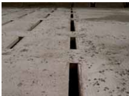
Obr. 3 Štrbinové dno pravej komory (vľavo a v strede) a valcová nádrž pod štrbinovým dnom (vpravo)
