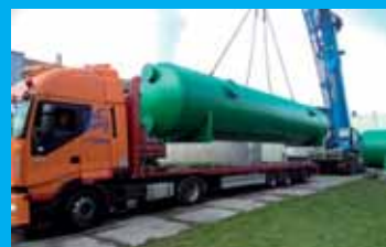
MONDI SCP, Ružomberok - nový pieskový filter 450 m³/hod.
