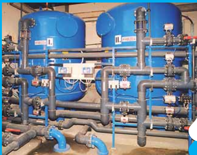
MONDI SCP, Ružomberok - starý pieskový filter 450m³/hod.
