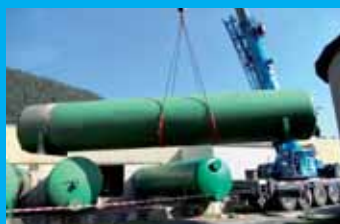
MONDI SCP, Ružomberok - starý pieskový filter 450m³/hod.
