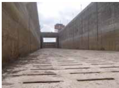
Obr. 3 Štrbinové dno pravej komory (vľavo a v strede) a valcová nádrž pod štrbinovým dnom (vpravo)
