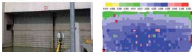
obr. 4 - dolné vráta ľavej plavebnej komory a rozdielový model časti vrát plavebnej komory zo skenu č. 1 a 31
