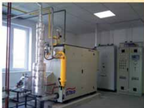
Kogeneračná jednotka a bioplynová stanica so zásobníkom plynu - LVN STU Bratislava - Trnávka
