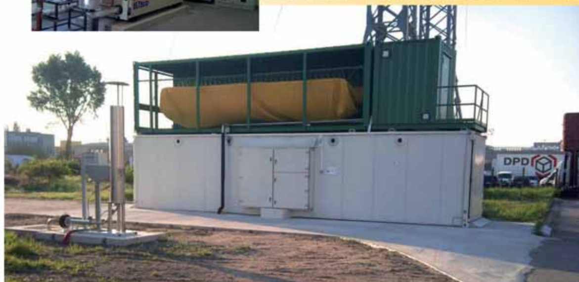
Kogeneračná jednotka a bioplynová stanica so zásobníkom plynu - LVN STU Bratislava - Trnávka
