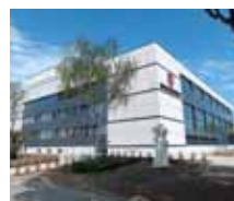
Rekonštrukcia domu kultúry v Šali
