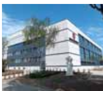
Rekonštrukcia domu kultúry v Šali
