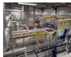
Výstavba novej plynovej kotolne
