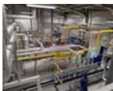
Výstavba novej plynovej kotolne
