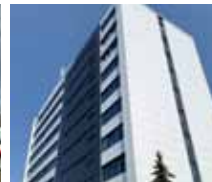
Rekonštrukcia budovy ÚPSVaR Nitra
