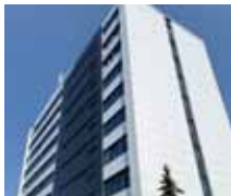
Rekonštrukcia budovy ÚPSVaR Nitra
