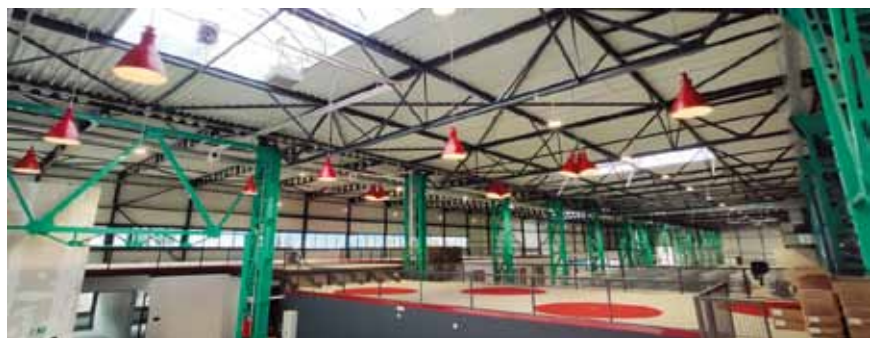
Rekonštrukcia elektroinštalácie, vzduchotechniky a vykurovania
