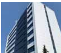
Rekonštrukcia budovy ÚPSVaR Nitra
