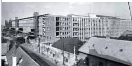
Pohľad na budovu od Kollárovhovho námestia z roku 1961
