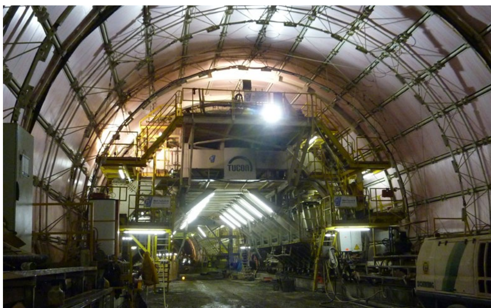
Tunel Rennberg, Nemecko TuCon, a.s.
