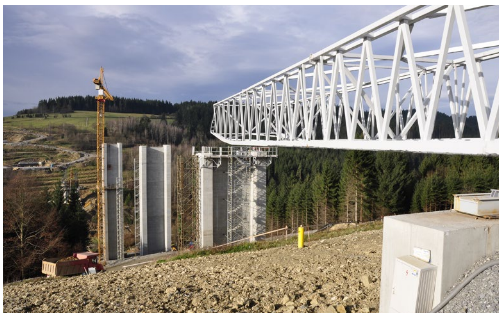
Diaľnica D3 Svrčinovec – Skalité – vysúvanie na mostnom objekte Doprastav, a.s. v združení so spoločnosťami VÁHOSTAV-SK, a.s., STRABAG s.r.o. , Metrostav a.s.(„D3 Svrčinovec – Skalité“ )
