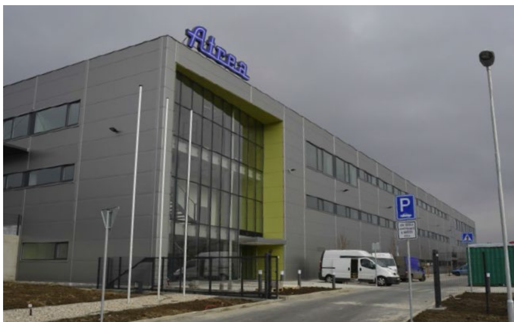
Investor: ATREA s.r.o. Materiál opláštenia: Ruukki Energy Panely Realizácia opláštenia: GEOSA, spol. s r.o.
