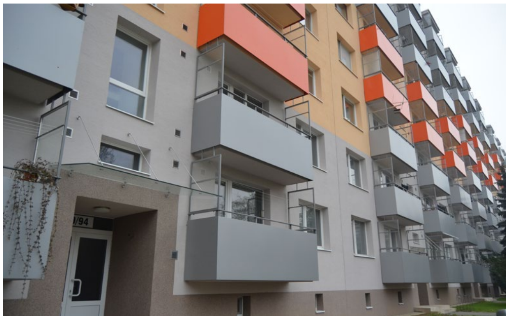
Komplexná obnova panelového bytového domu PS STAVBY, s.r.o.
