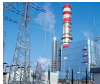
Paroplynovú elektrárňu v Malženiciach s účinnosťou na úrovni 59 percent a s čistým výkonom 417 megawattov postavil Siemens formou projektu na kľúč s dodávkou všetkých hlavných komponentov a technológií.
